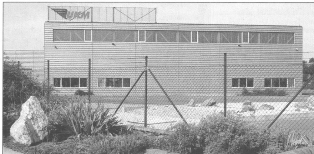
Drei neue Hallen errichtete die Firma UKM Fahrzeugteile GmbH am Standort Hirschfeld. In diesem Jahr sollen zwei weitere Produktionshallen gebaut werden.
